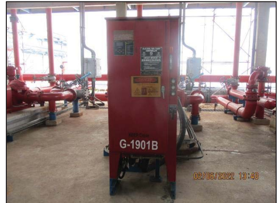
รูปที่ 3.58 เครื่องสูบน้ำดับเพลิง ชนิดไฟฟ้า
