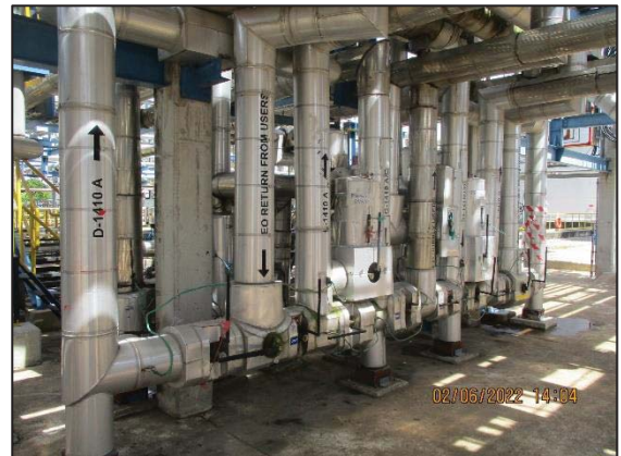
รูปที่ 3.36 อุปกรณ์ที่เกี่ยวข้องกับเอทิลีนออกไซด์ ที่ทำจาก Stainless Steel
