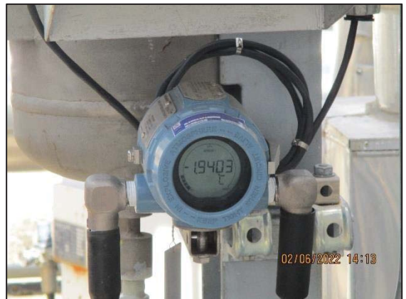
รูปที่ 3.46 เครื่องตรวจวัดอุณหภูมิ บริเวณถังเก็บเอทิลีนออกไซด์
