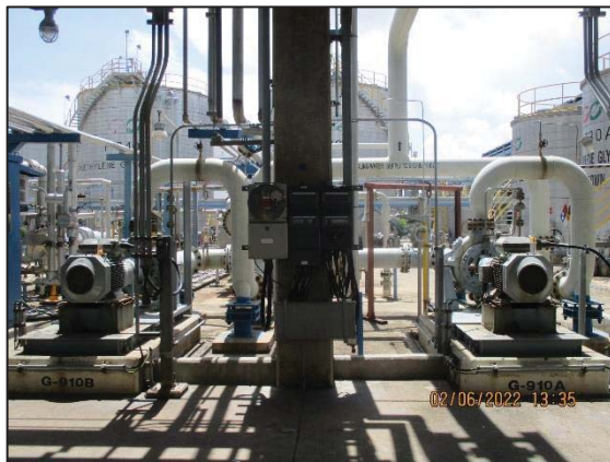
รูปที่ 3.51 Pump ชนิด Double Mechanical Seal
