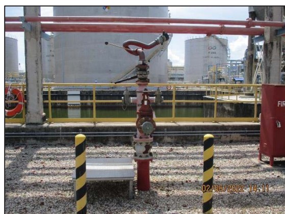
รูปที่ 3.44 Fire Water Monitor
