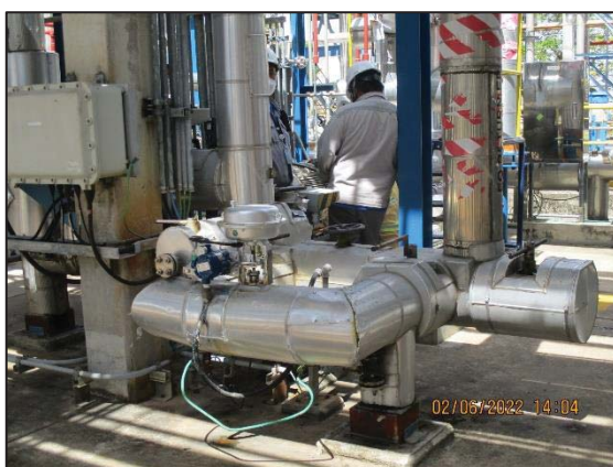
รูปที่ 3.37 ฉนวนหุ้มอุปกรณ์การผลิต เอทิลีนออกไซด์
