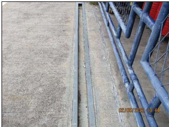
รูปที่ 3.35 ร่องระบายน้ำเพื่อป้องกันสารเคมีรั่วไหล
