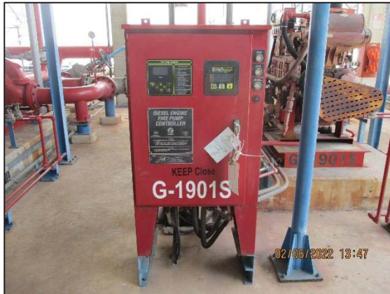
รูปที่ 3.57 เครื่องสูบน้ำดับเพลิง ชนิดเครื่องยนต์ดีเซล
