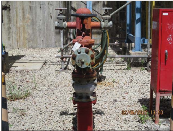
รูปที่ 3.45 Fire Water Hydrant
