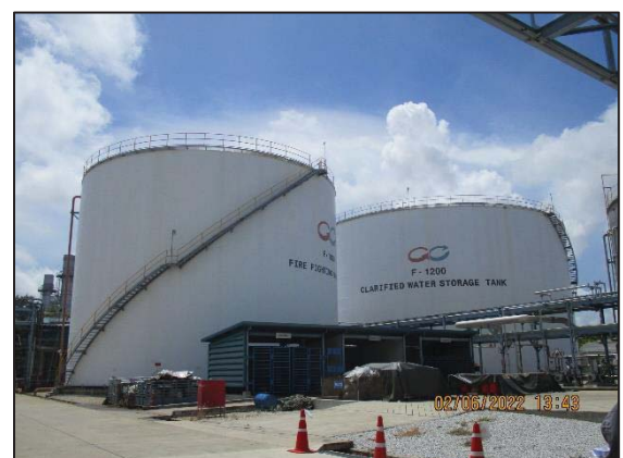
รูปที่ 3.56 ถังน้ำสำรองดับเพลิง
