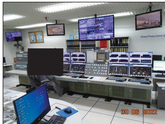
รูปที่ 3.40 ระบบ Distributed Control System (DCS)
