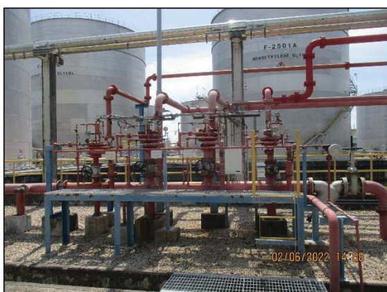
รูปที่ 3.43 Deluge System บริเวณถังเอทิลีนออกไซด์
