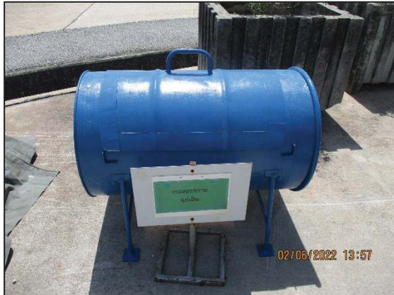
รูปที่ 3.9 ถังทราวดูดซับสารเคมี
