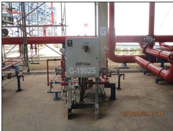
รูปที่ 3.59 เครื่องสูบน้ำดับเพลิงรักษาแรงดัน
